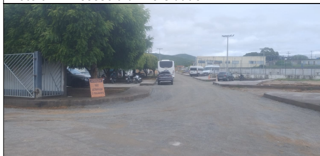
Foto 03 – trecho com aplicação de BGS
