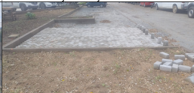
Foto 06 – aplicação de piso intertravado
