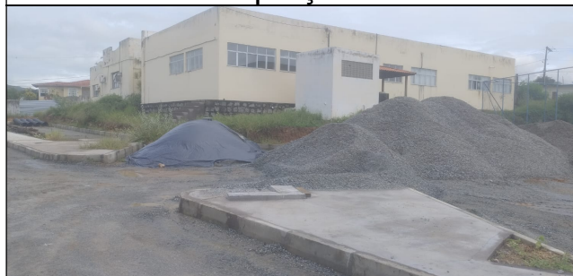
Foto 05 – execução de calçadas e meio fio
