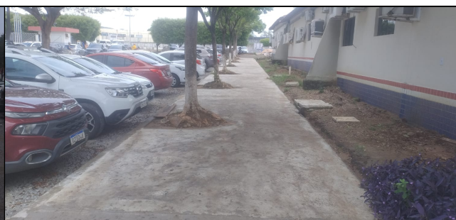
Foto 08 – execução de calçamento
