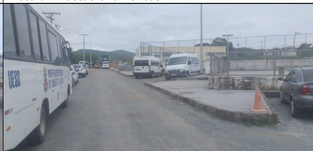
Foto 04 – execução de calçadas e meio fio
