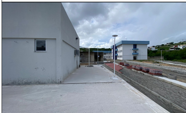
Foto 03 – Execução de estacionamento de Motos
