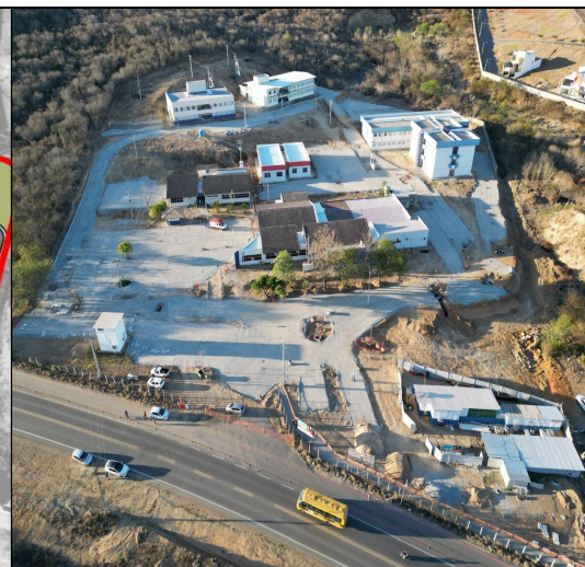
Foto 02 – Obra em execução
